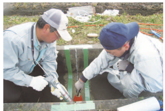
▲水路の漏水箇所の目地補修
